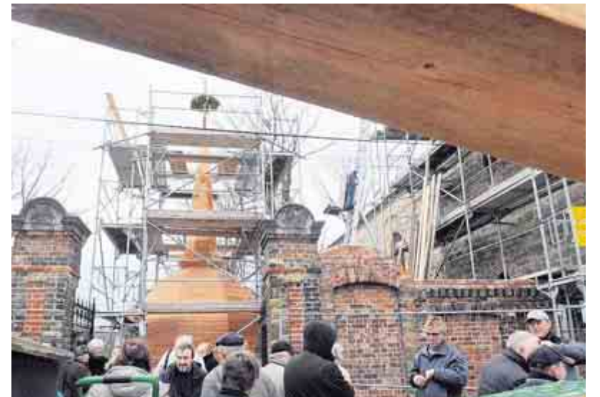
Die Zwiebel mit dem Richtkranz. Sie soll demnächst hochgehievt werden.
